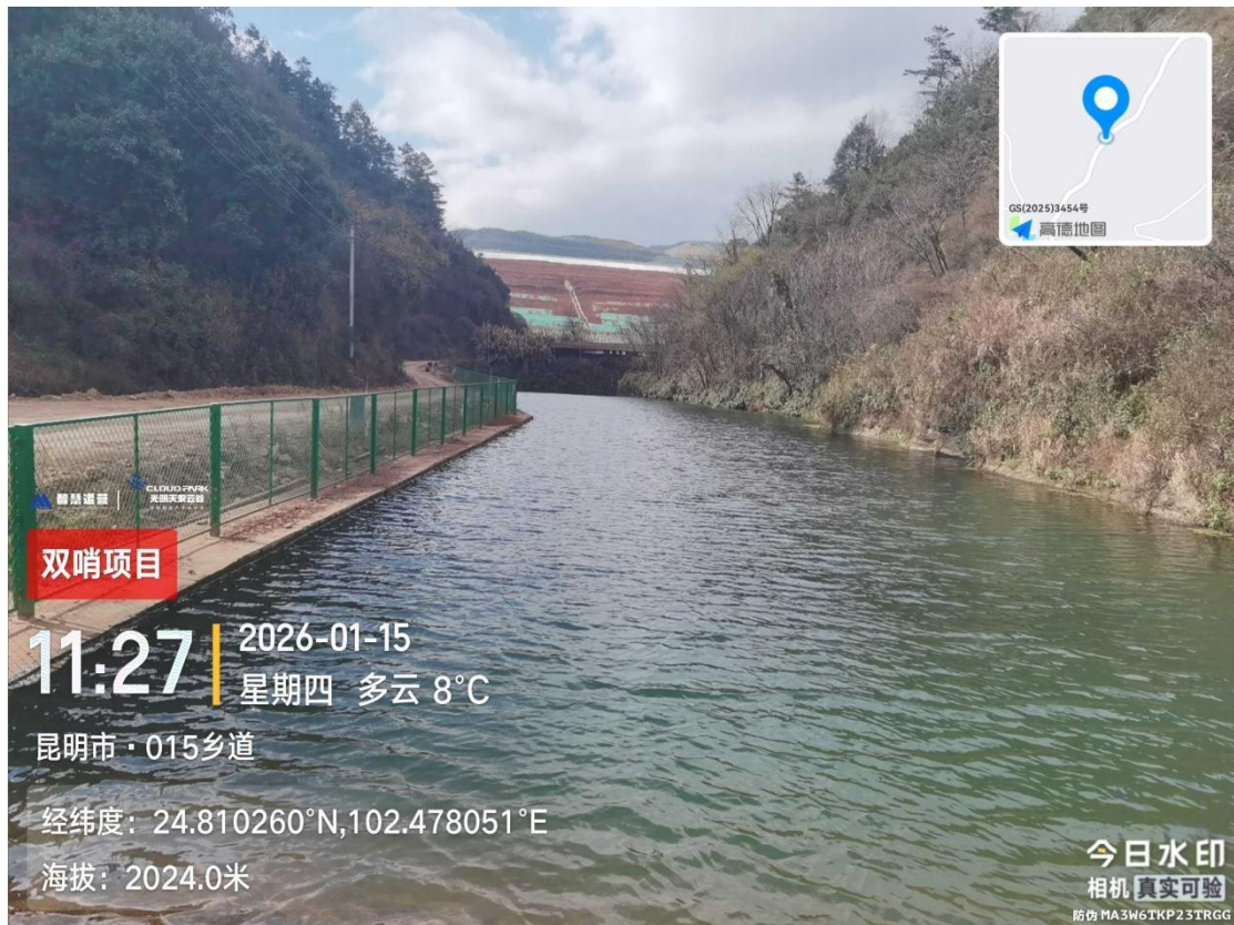
图 7.3-1 项目淋滤水收集池下游水塘 SW3
