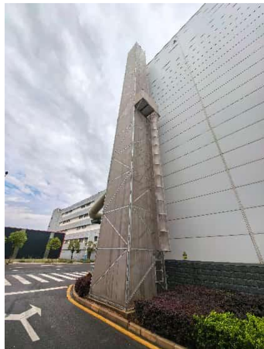
排气筒监测平台
