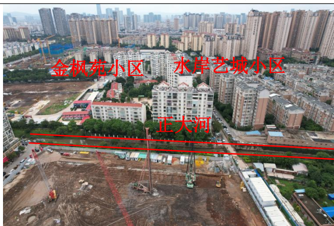
图 4 项目东侧正大河及金枫苑小区
