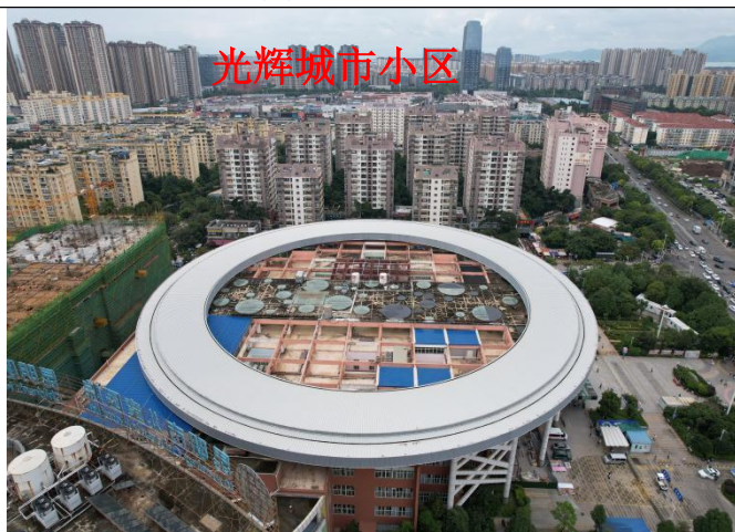
图 6 项目南侧敏感点（光辉城市小区）
