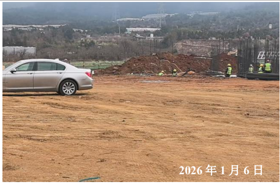
项目区东侧现状
