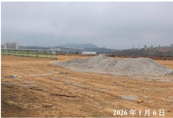
项目区西侧现状
