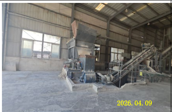
项目生产区烘干现状
