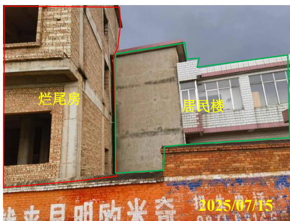
图 10 项目北侧烂尾房和居民楼
