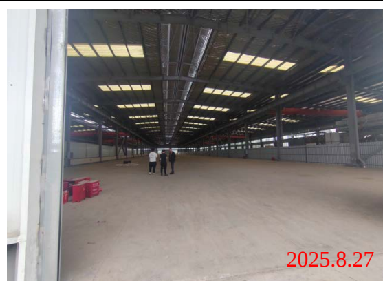
厂房内部现状
