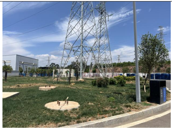
110kV 裕能变前绿化及 JB (5)、JA (3) 塔基生态恢复
