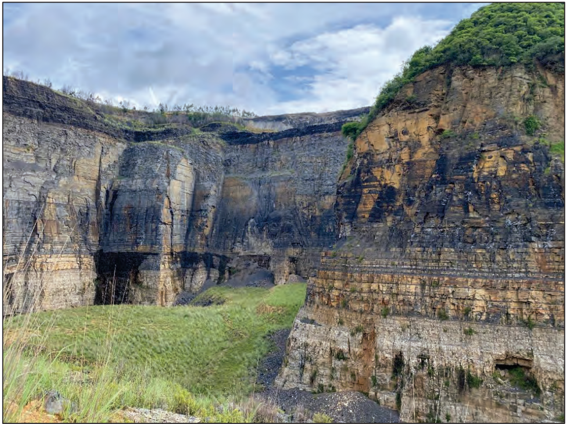
图 2.2-5 B 1 崩塌局部照片
