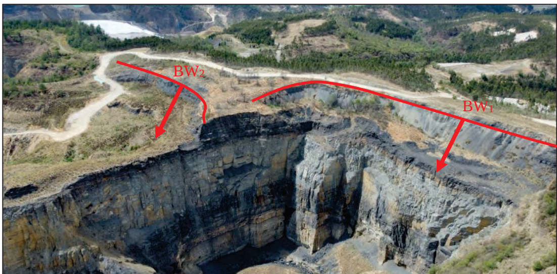
图 2.2-13 BW 1 、BW 2 不稳定边坡
