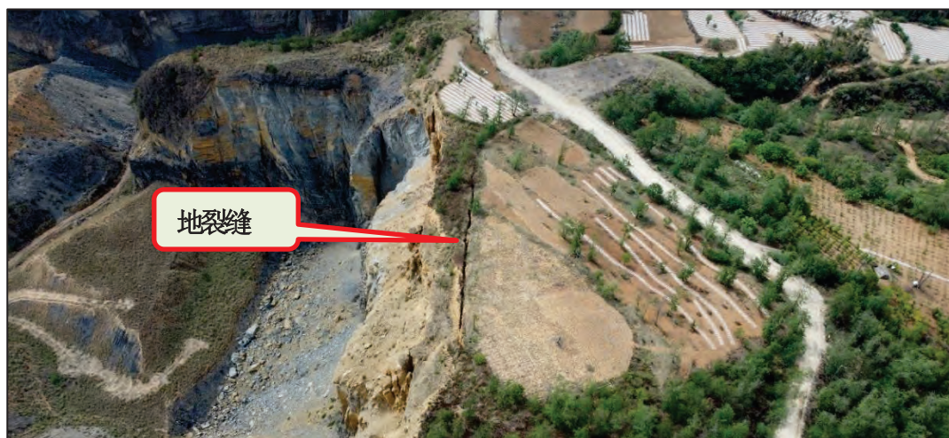
图 2.2-10 L 1 地裂缝全景
