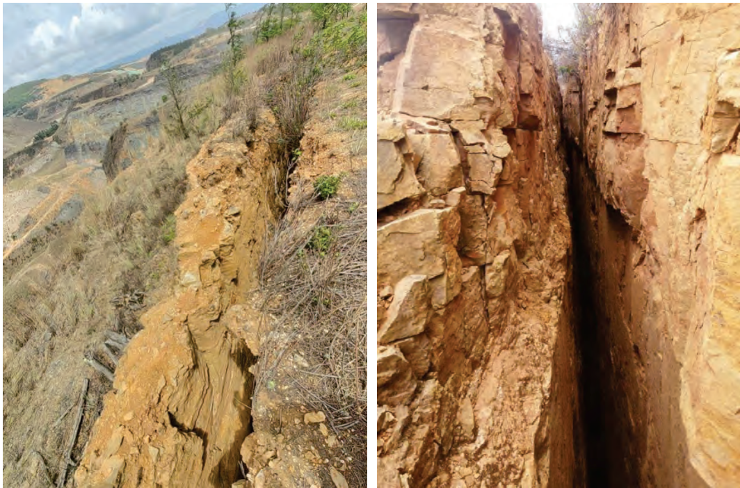
图 2.2-11 L 1 地裂缝局部
