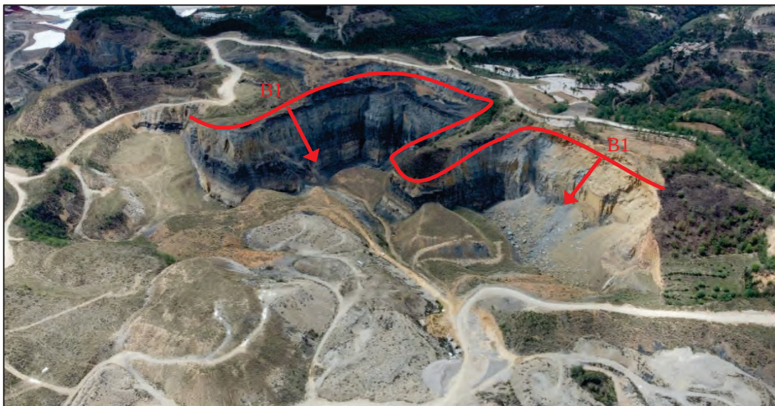
图 2.2-4 B1 崩塌全景
