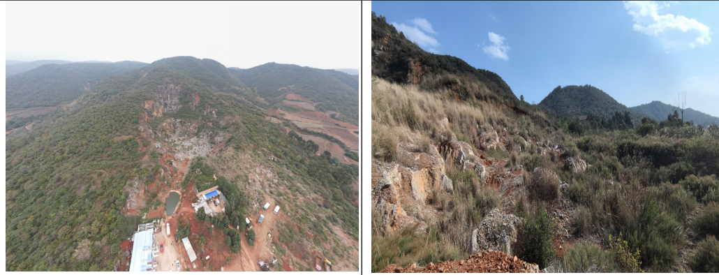
图4-4官渡区阿拉街道办事处清水社区建筑石料用灰岩矿修复工程实施前矿山损毁区域特征（左）及与生态红线重叠区域特征（右）
